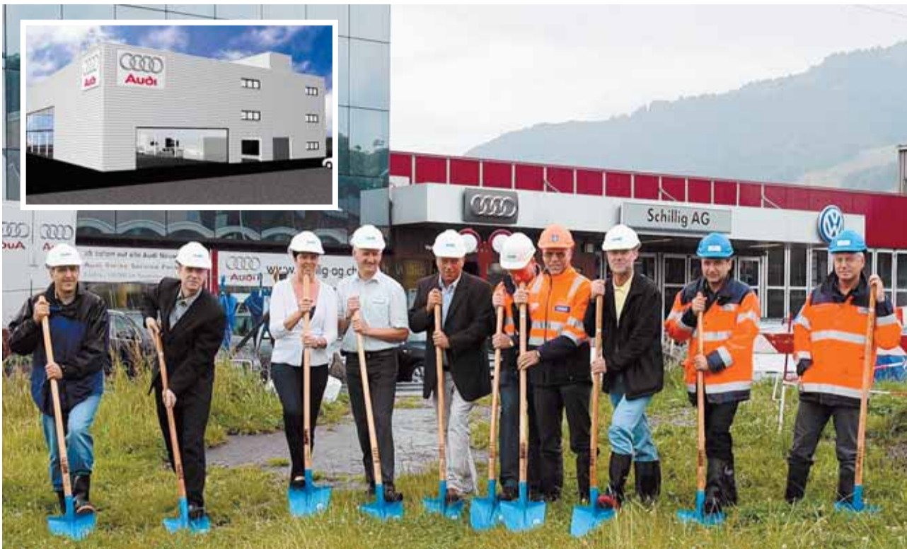
Die Bauherren, Brigitta und Hans Furrer (Dritte und Vierte v.l.), trotzten gestern dem schlechten Wetter und setzten zusammen mit den beteiligten Baufirmen zum Spatenstich für das neue Audicenter (kleines Bild) an. Bilder zvg und David Mynall
