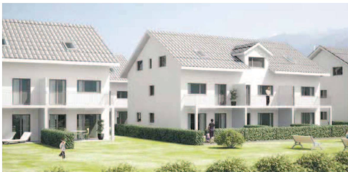
Ein Traum für Familien: Im Sonnenpark-Quartier in Buttikon sollen schon im Herbst die Bauarbeiten für zehn Einfamilienhäuser beginnen. In einer zweiten Etappe sind weitere 20 Häuser geplant. Bild zvg
